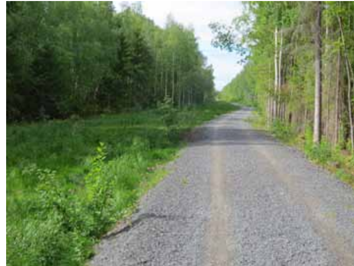
Kuva 7. Maastokäytävä ja siirtoviemärin huoltotie.
