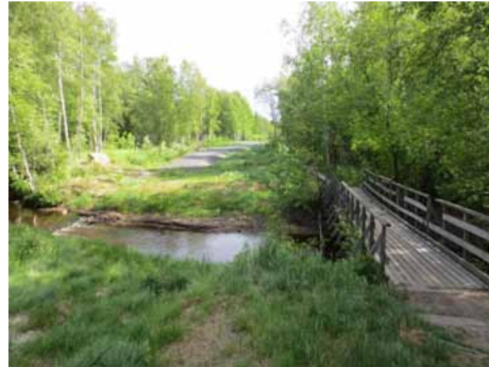
Kuva 38. Kuivasojan ylitys sijaitsee paineviemärin maastokäytävän alueella, josta välitön yhteys viherverkostoon.
